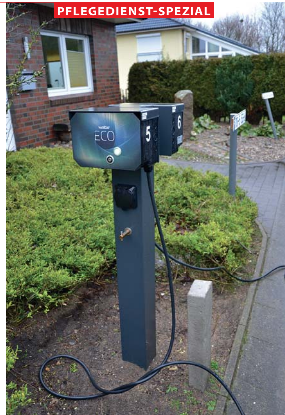
Die meisten Ladesäulen stammen von Wallbe und haben 11 kW Ladeleistung
