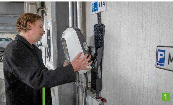
1 Das geht einfach. Strom abstellen, Wallbox herausheben ... 2 ... das lange Hybridkabel (Strom und Daten) abklemmen, schon ist die Wallbox abgebaut. Oder anderes herum neu installiert.
