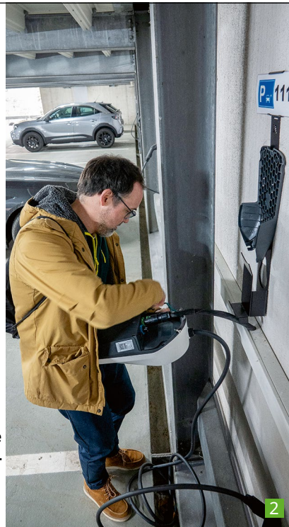
1 Das geht einfach. Strom abstellen, Wallbox herausheben ... 2 ... das lange Hybridkabel (Strom und Daten) abklemmen, schon ist die Wallbox abgebaut. Oder anderes herum neu installiert.
